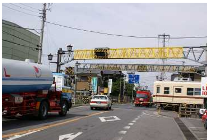
大型踏切警報機
