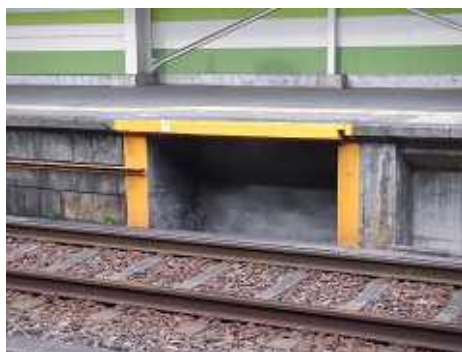
ホーム下の待避スペース
