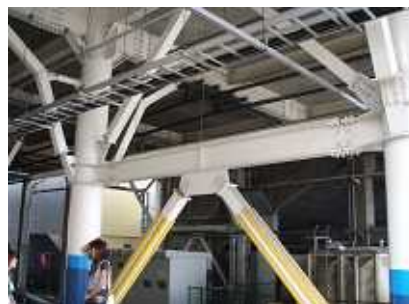
駅舎の耐震補強
