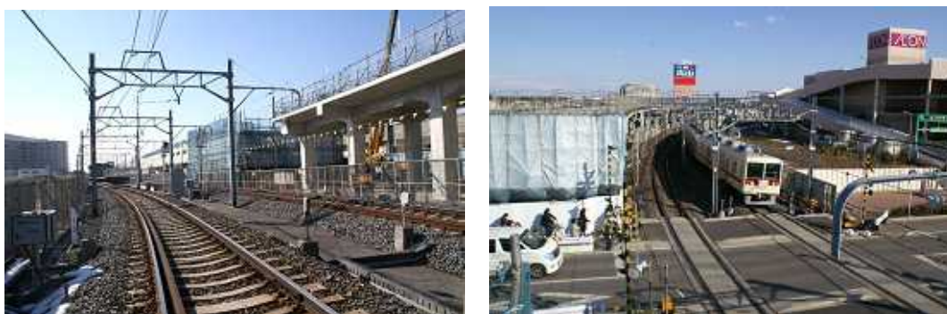
工事の進む初富駅～新鎌ヶ谷駅間
