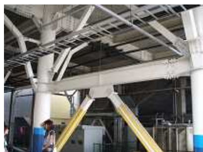
駅舎の耐震補強
