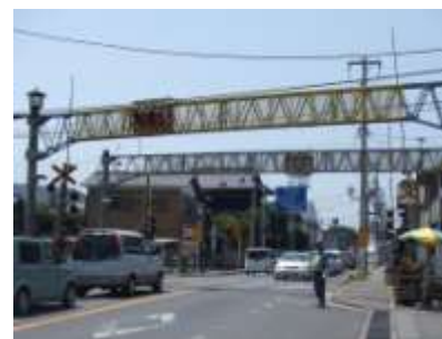
大型踏切警報機
