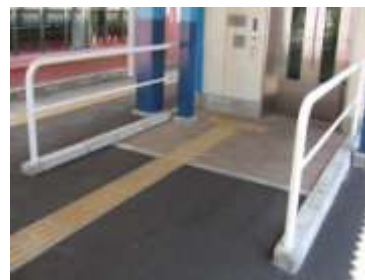
エレベーター出口部分の手すり
