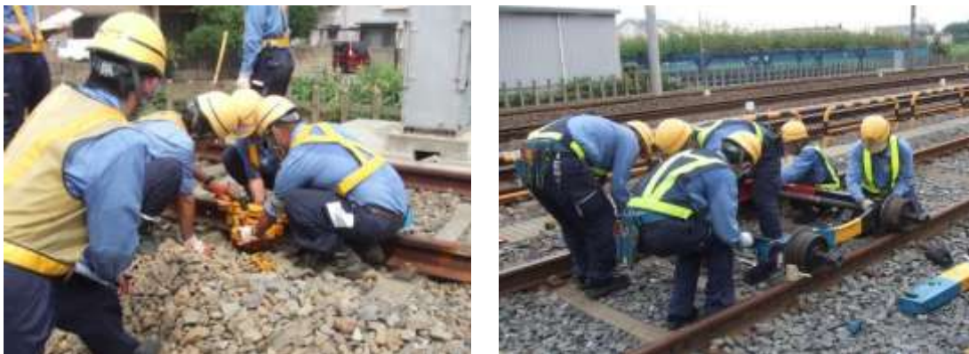
レール破損応急処理器設置訓練
