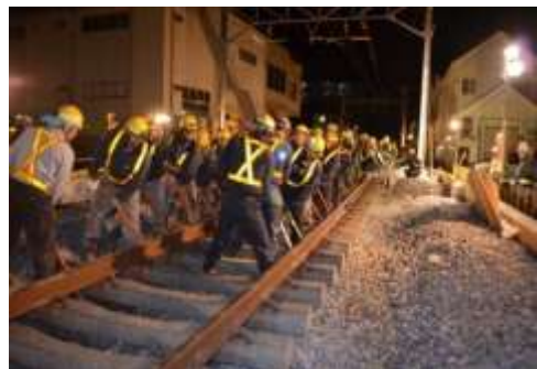
仮線切替工事の様子
