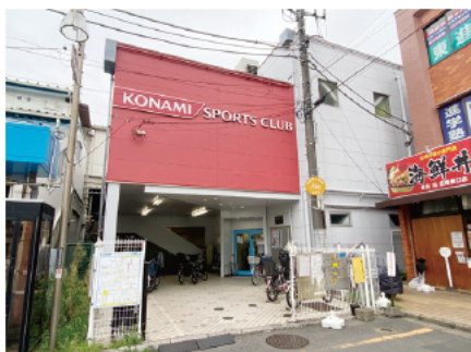
●五香駅東口ビル 1980年竣工。コナミスポーツ(株)に賃貸しており、「コナミスポーツジュニアスクール五香」として営業しています。
