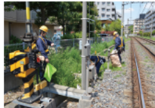
電力区による清掃活動
