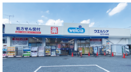
●常盤平6丁目賃貸借建物 1999年竣工。ウエルシア薬局(株)に賃貸しており、「ウエルシア松戸牧の原店」として営業しています。
