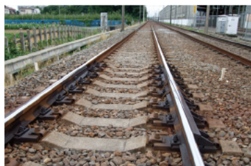
ロングレール化工事を行った線路
