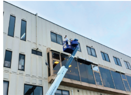
修繕工事確認状況
