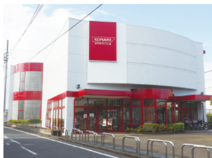
●五香駅西口第2ビル 2000年竣工。コナミスポーツ(株)に賃貸しており、「コナミスポーツクラブ五香」として営業しています。
