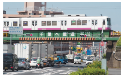
南花島架道橋
