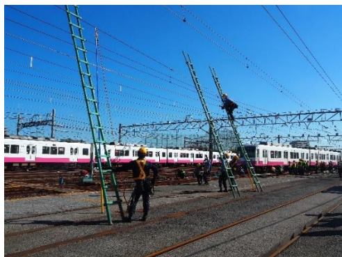
架線切断部分復旧訓練
