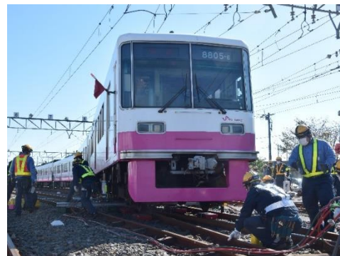
列車脱線復旧訓練
