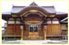
▲平成16年5月に再建された新社殿
