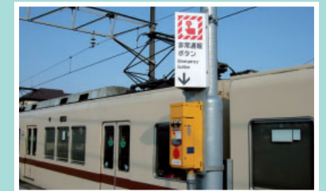
「非常通報ボタン」が押されると防護無線を発報し、接近している列車に停止警報を送出します。
