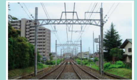
電車線支持物の強化コンクリート柱(N柱)化、かご型ビーム化を順次行い、耐震性向上を図っております。
