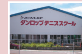
賃貸施設を良好な状態で維持するための予防保全工事に取り組んでおります。(常盤平北口ビル屋根更新工事)
