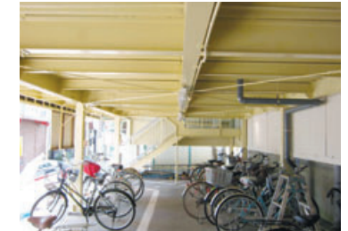
元山駅北口第1駐輪場鉄部塗装工事
