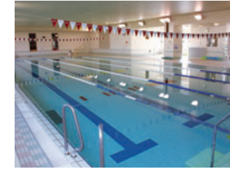
五香駅西口第2ビル(コナミスポーツエグザス館)プールろ過ポンプ改修工事
