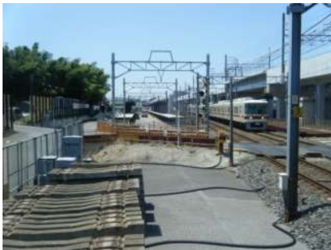
北初富駅付近仮線工事の様子
