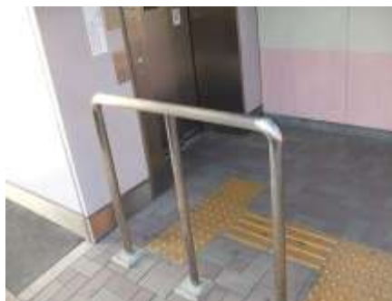
エレベーター出口の手すり
