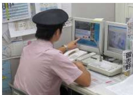
松戸駅・北習志野駅・新津田沼駅に設置された監視システム
