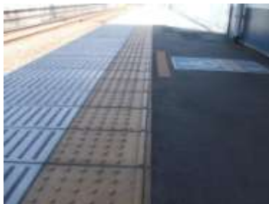
内方線付き点字ブロック
