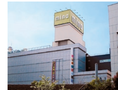
津田沼14番街ビル防災設備工事
