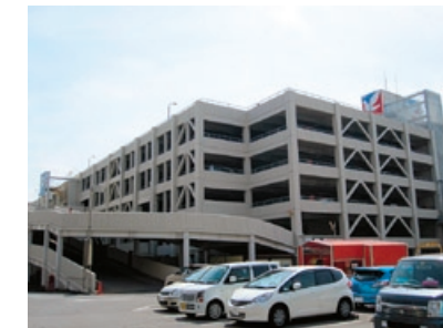
新津田沼駐車場ビル外壁補修工事
