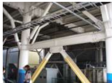
駅舎の耐震補強
