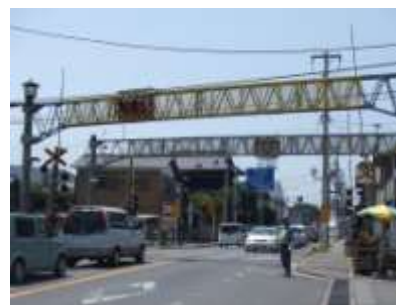
大型踏切警報機
