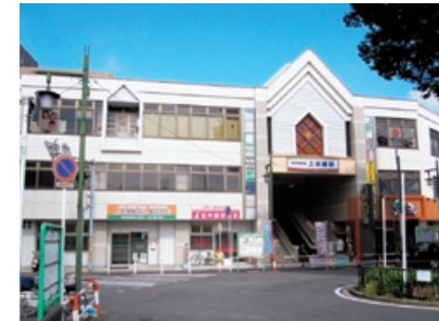
上本郷駅ビル電気設備改修工事
