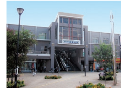
薬園台駅ビル防災設備補修工事
