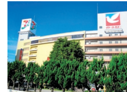
津田沼12番街ビル防災設備工事
