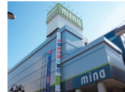
津田沼14番街ビル空調設備工事
