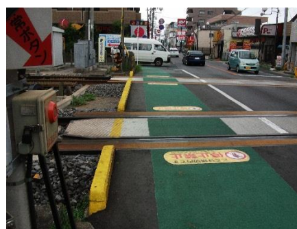
踏切のカラー舗装例
