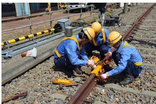
レール破損応急処理器設置訓練
