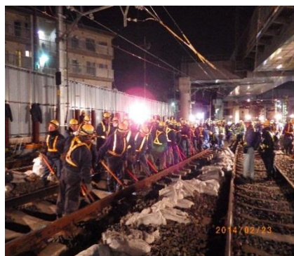
仮線切替工事の様子
