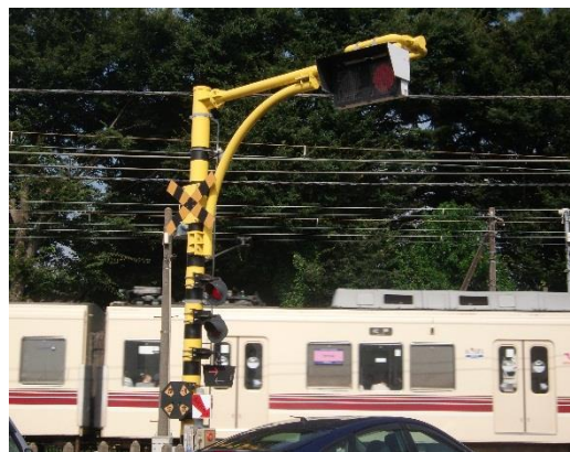
大型踏切警報機
