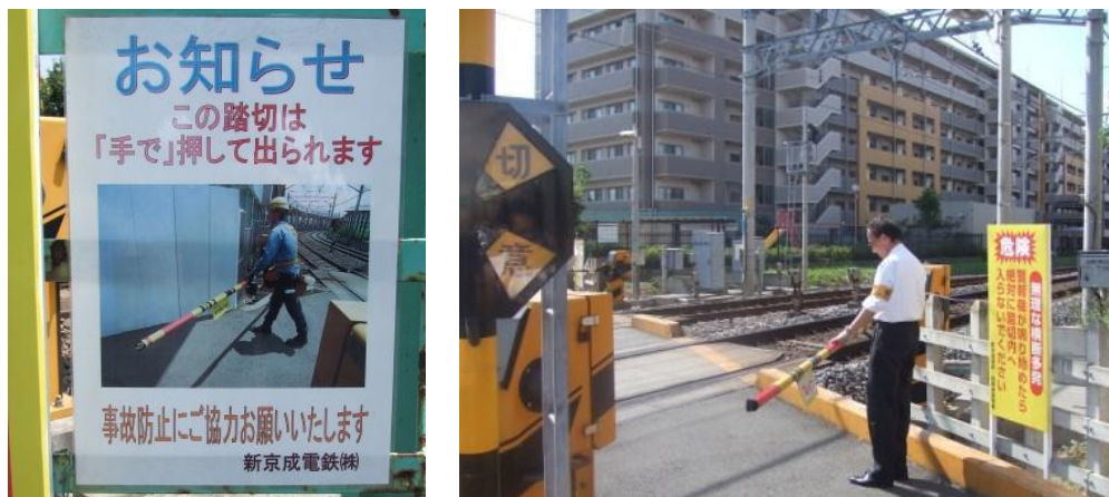
遮断かんが閉まった場合も、上または外側に押して動かせる構造になっています。
