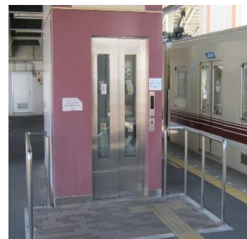
エレベーター出口部分の手すり
