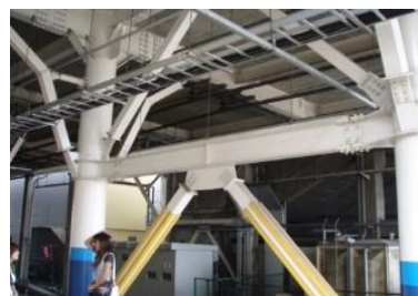
駅舎の耐震補強
