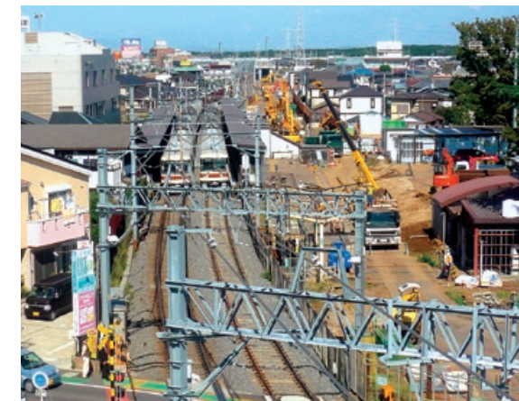
上下線ともに仮線となった初富駅付近
