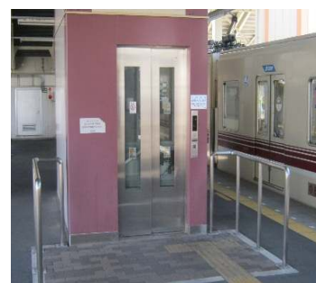
エレベーター出口部分の手すり
