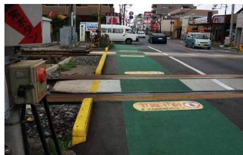
踏切のカラー舗装例
