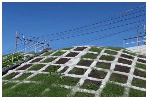
法面の改良箇所の様子
