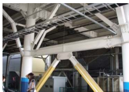
駅舎の耐震補強
